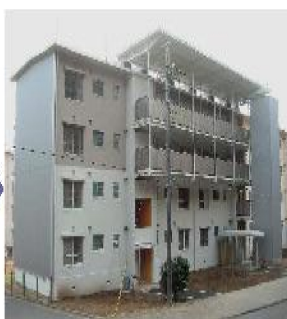
改修後(試験施工)
