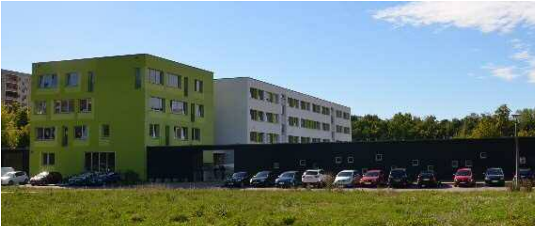
● 建物除却後、小学校を拡張
