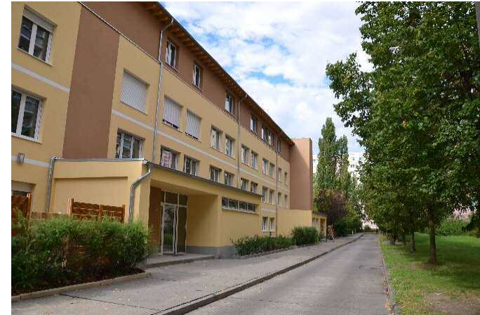
● 既存建物を活用し高齢福祉施設に改修
