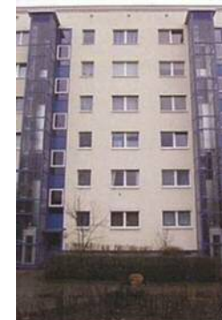
エレベーターの付加、セキュリティシステムの導入、外断熱などが施された住棟
