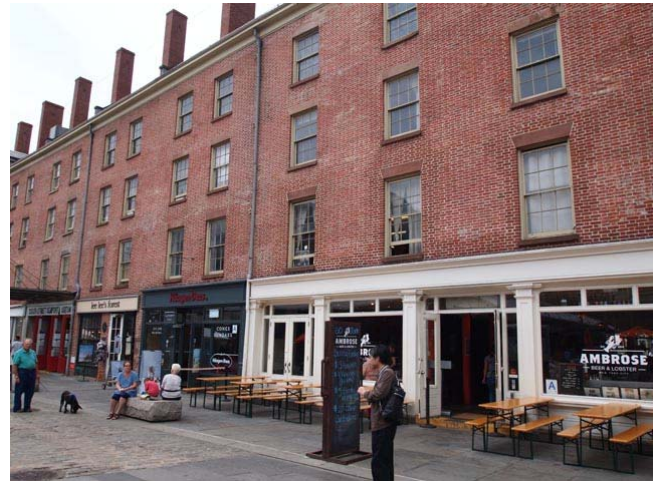
コンバージョンされた建物のファサード
