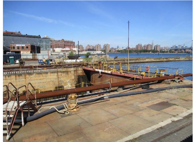
Dry Dock 1 のドッグゲート
