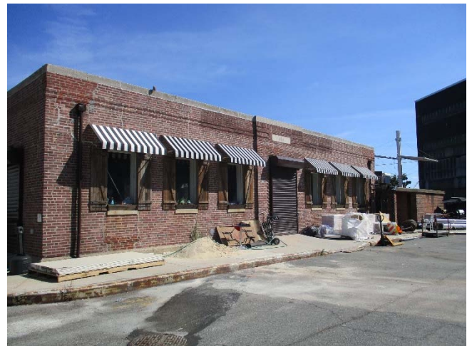
改修中と思われる建物の外観
