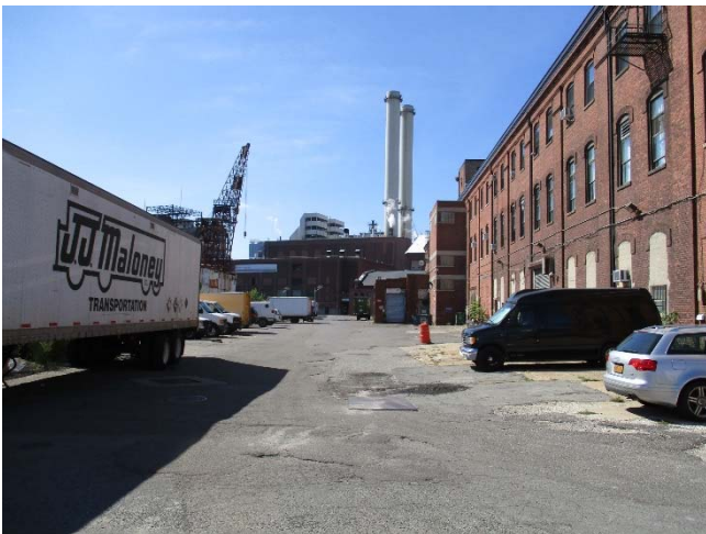
地区内にある発電所(284 メガワット)
