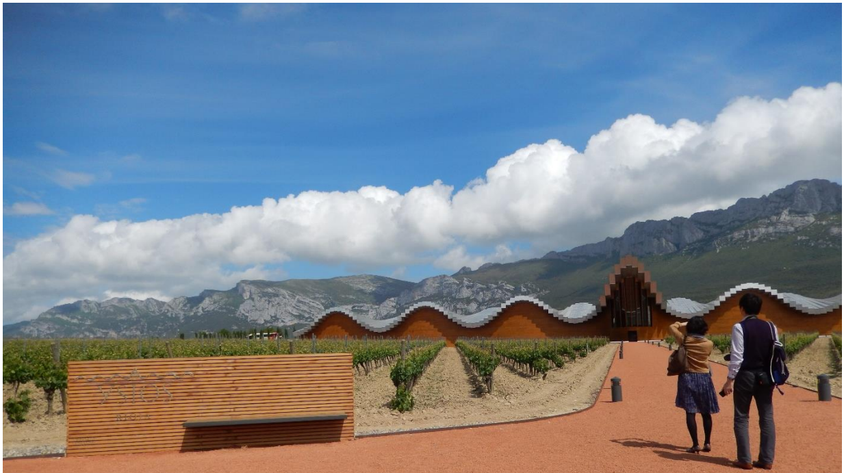
全長196m、大きく波打った木製の壁、アルミの屋根が特徴的
