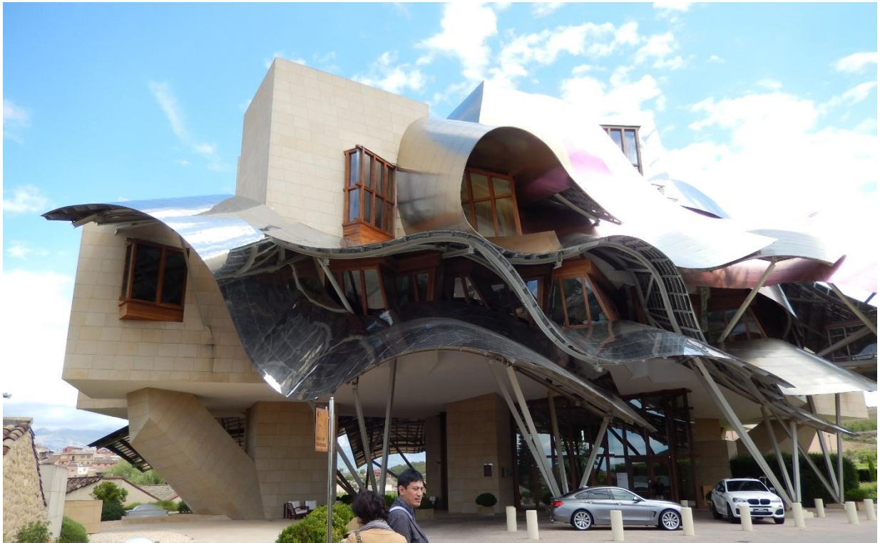
波打ったチタンの屋根が特徴的。外壁は砂岩貼り
