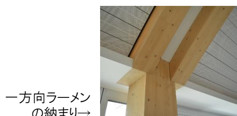
□増築部分の最上階(一方向ラーメン構造)
