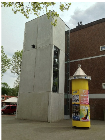
妻側でのEVの設置
