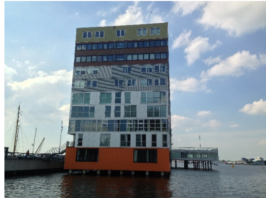
運河上に建てられた住棟
