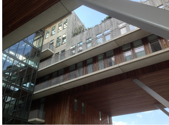
上層階の住戸は木材外装
