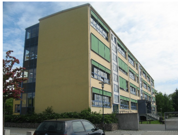
小学校の改修
