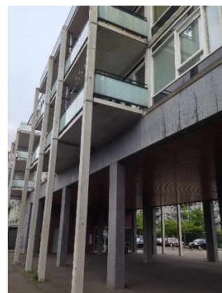
地上階撤去部分及びバルコニー増築部分
