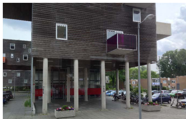
間口・容積を確保するため張り出した住棟
