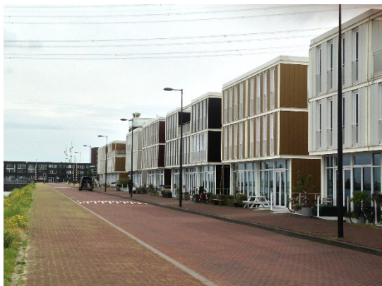
接道側・住戸入口部の統一された外観
