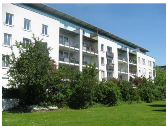
開放的な緑化空間に面する住棟
