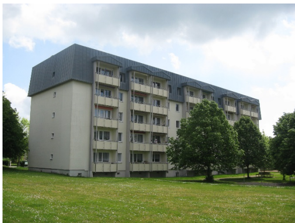
外壁デザイン及びベランダの設置
