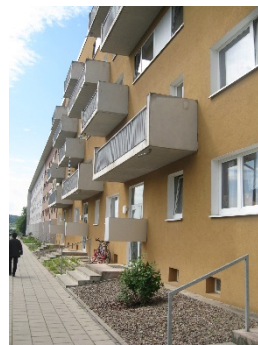
3 入口部整備及びバルコニー設置
