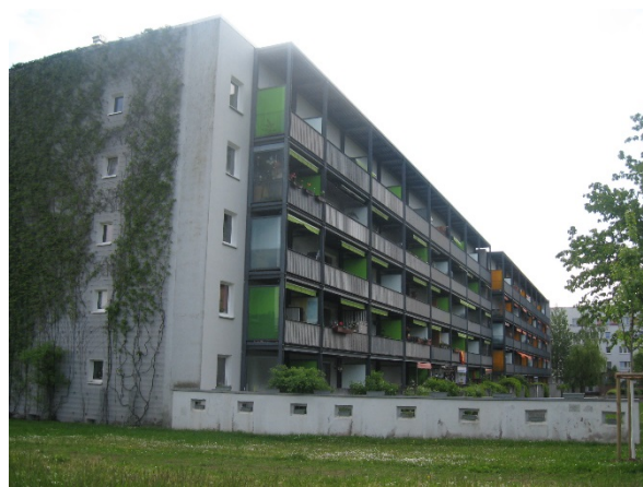
ベランダ設置及び外壁緑化
