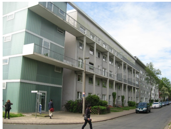
EV 棟及び共用廊下設置
