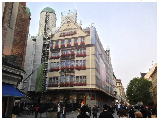
外壁改修中の仮囲い
