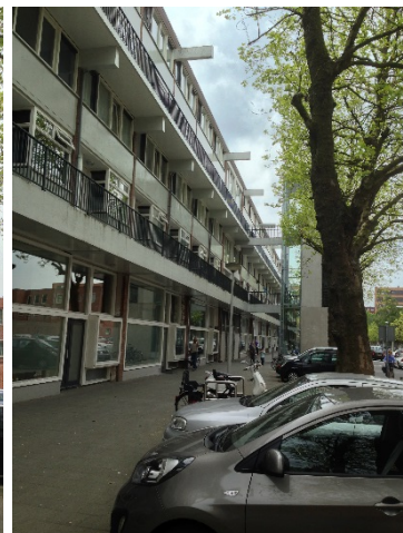
歩道上に設置された EV、外装材の修繕等
