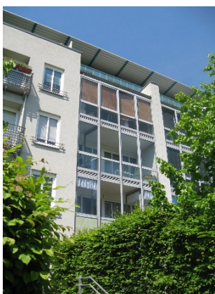
室内化に対応したバルコニー
