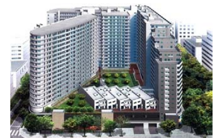
千里中央地区業務ゾーンでの分譲マンション建設（2007）
